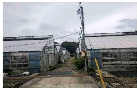
写真2 遮熱剤を塗布していない施設（左）、塗布した施設（右）
