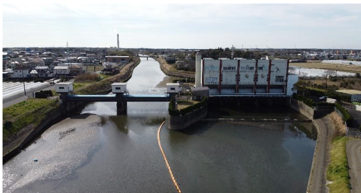
<新川用排水機場>
