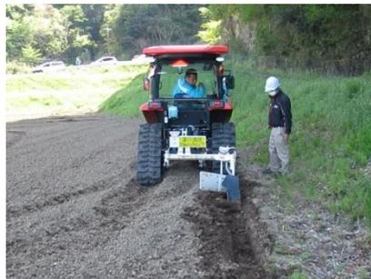
写真9 溝掘り機による明きよ施工
