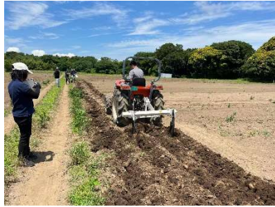
写真1 サブソイラ施工の様子
