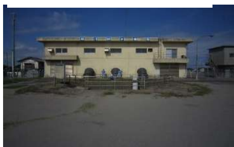
堀川排水機場(全景)
