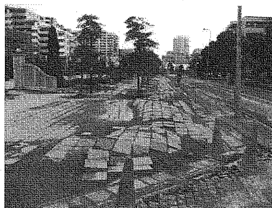
日の出 歩道の波うち。凹凸の高さは40cm程度。
