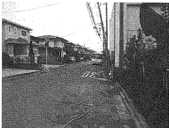
今川 道路が40cm程度沈下，電柱は沈み傾いた。
