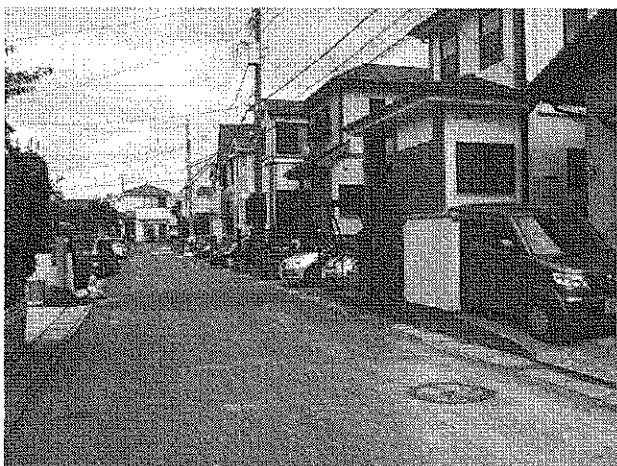
高洲 噴砂の跡はみられるが、道路面に変形はほとんどみられない。電柱やレンガ塀に沈み込みや傾きはみられない。
