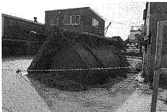
口絵写真-10 船橋市日の出で発生した重油タン クの浮上がり
