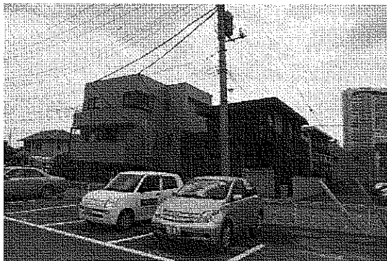
口絵写真-2 浦安市入船における家屋の沈下状況
