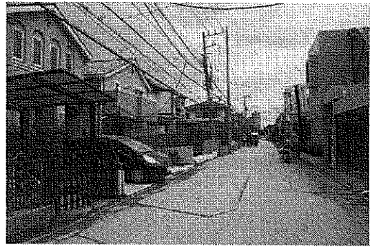
口絵写真-1 浦安市今川における家屋の沈下状況
