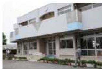
明海幼稚園校舎(摩擦杭、地盤改良なし) 小学校校舎に対して14-22mm沈下
