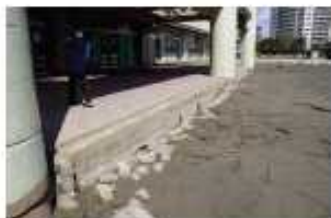
明海小学校校舎(支持杭、地盤改良なし)
