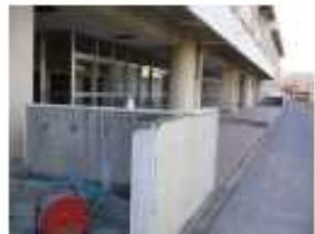
入船中学校校舎棟(支持杭、パイロフローテーション)
