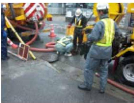
写真 3-12-20 高圧洗浄車による洗浄と
