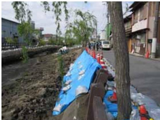
応急仮工事 大型土のう設置
