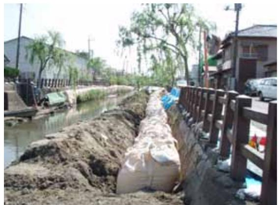
写真 3-12-6 (一)小野川応急復旧状況写真
