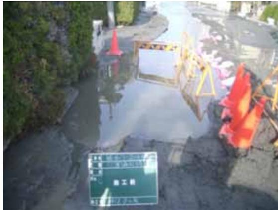
写真 3-11-2 漏水の状況
