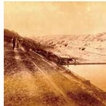
利根運河開削工事写真1 / 流山市立博物館所蔵
