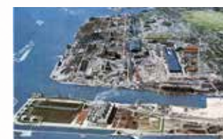
千葉製鉄所・千葉火力発電所 / 千葉市
