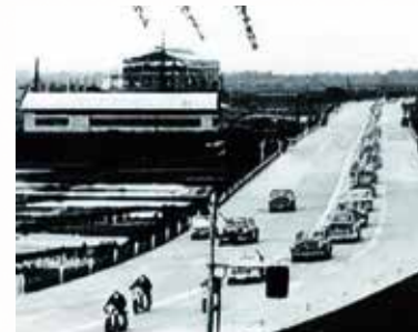
一之江～船橋間開通パレード / NEXCO東日本関東支社
