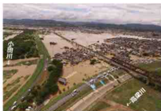
小田川における浸水被害状況 (岡山県倉敷市)
