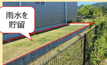
雨水貯留浸透施設(表面貯留)の事例
