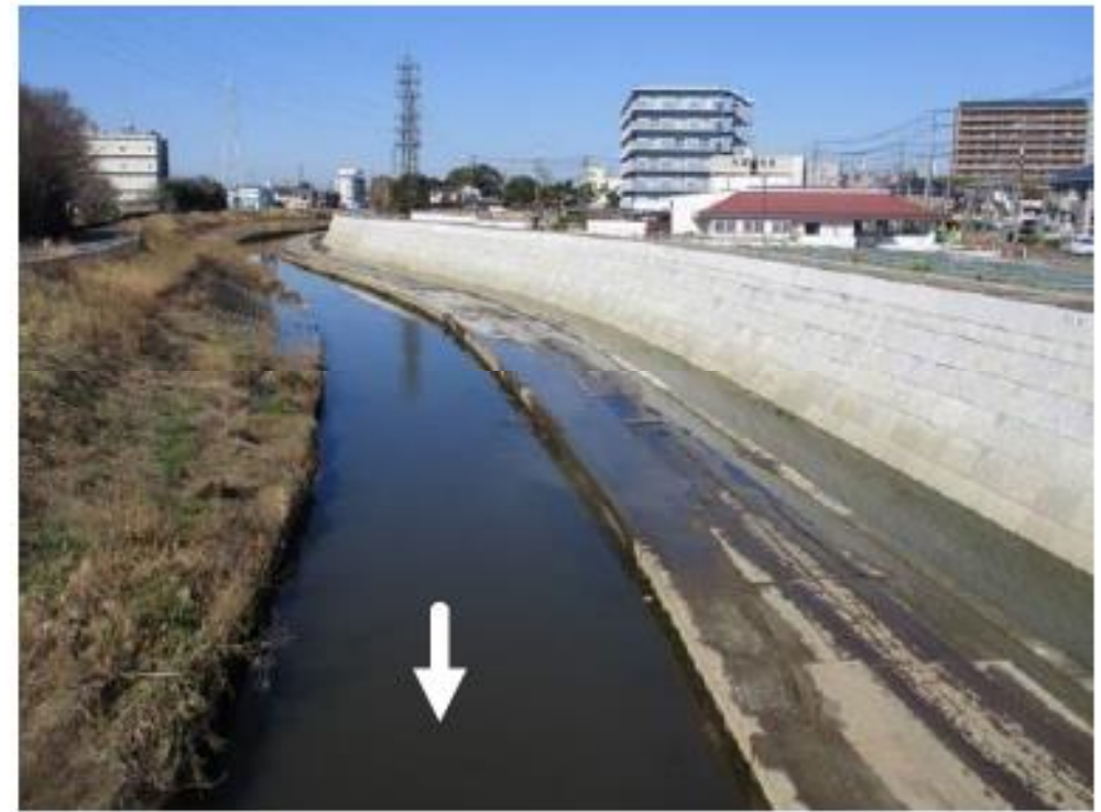
施工後（令和7年3月撮影）
