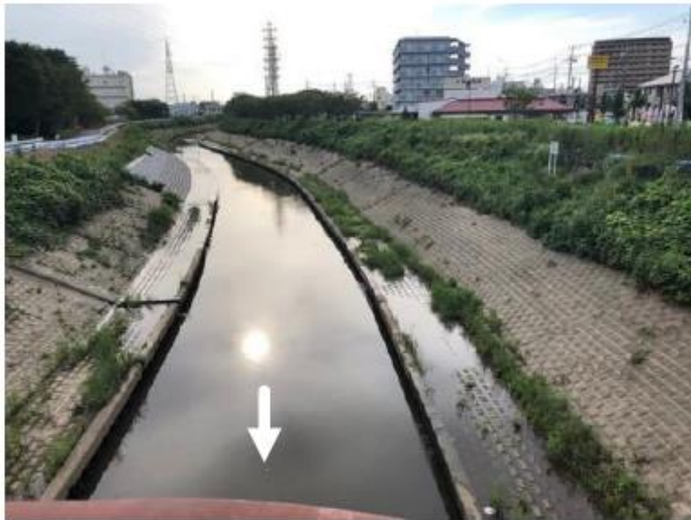
着工前（令和3年7月撮影）
