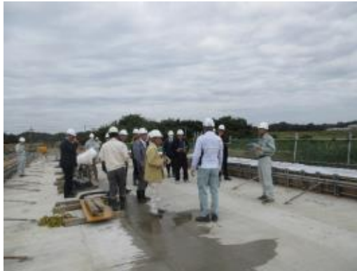
架替え中の北川橋で説明を受ける様子
