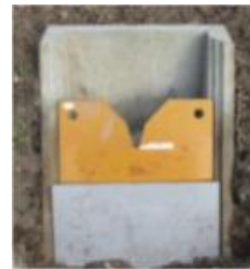
田んぼダムで使用する堰板の例
