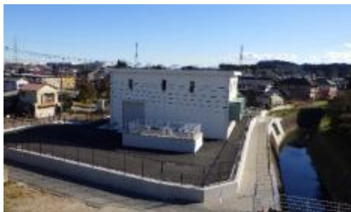
内水対策(早野排水機場R4.6月供用) 【茂原市】
