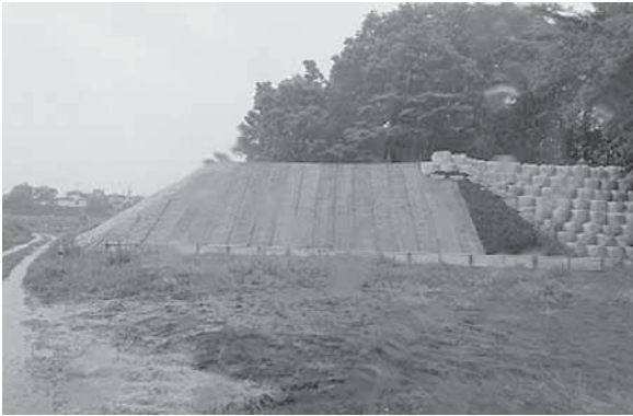
平成30年度施工 盛土工 V=4,300m 3
