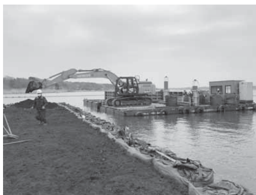
平成30年度施工 植生帯整備工 L=43.7m
