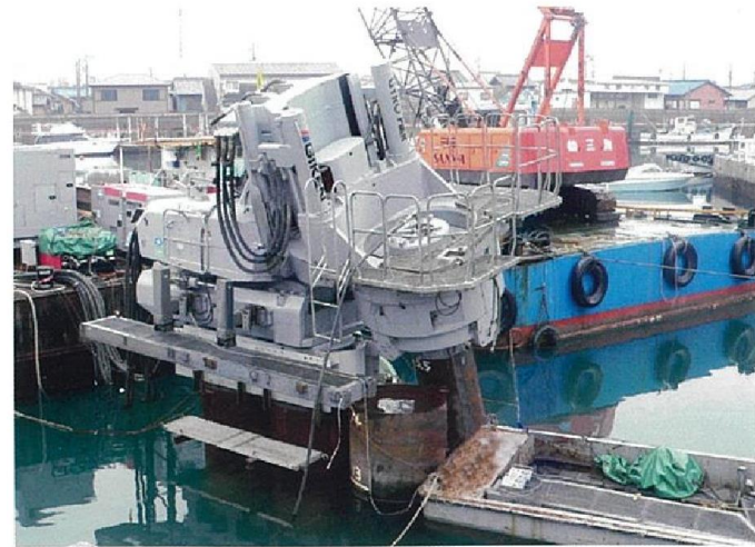
施工状況写真②
