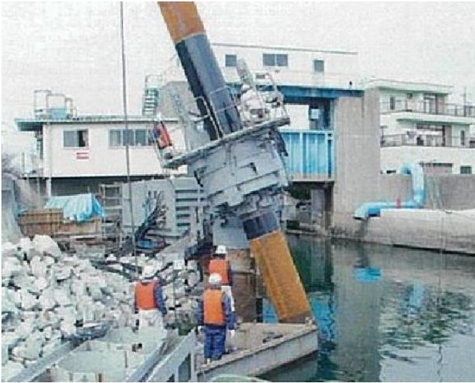
施工状況写真①
