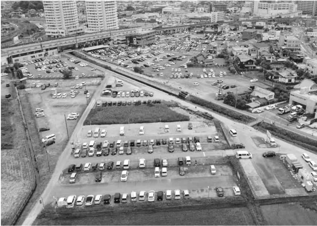
二級河川南白亀川水系小中川 大網白里市 駒込外（大網駅上流側）
