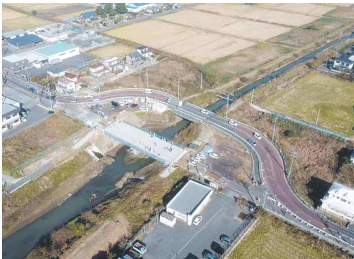
二級河川真亀川水系真亀川 東金市 家徳（中橋上部工）
