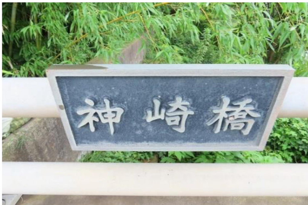
発生箇所 神崎橋 (盗難発生前)
