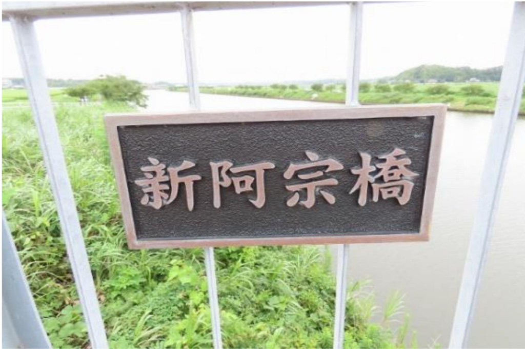
発生箇所 新阿宗橋 (盗難発生前)
