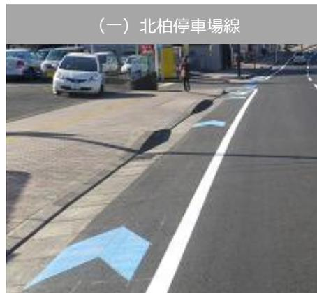
県道松戸野田線や県道北柏停車場線においては、安全・安心な自転車通行空間を創出するため、矢羽根等を設置し、自転車の分離を推進し、交通安全の向上を図っている。
