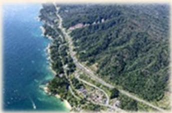
三陸沿岸道路 (岩手県山田町)
