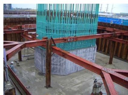
写真-3 橋脚 埋設型樁
