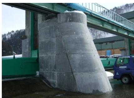
写真-4 頭首工 堰柱補修
