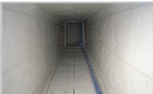
下水処理施設補修
