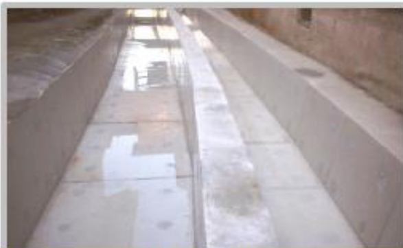
農業水利施設補修
