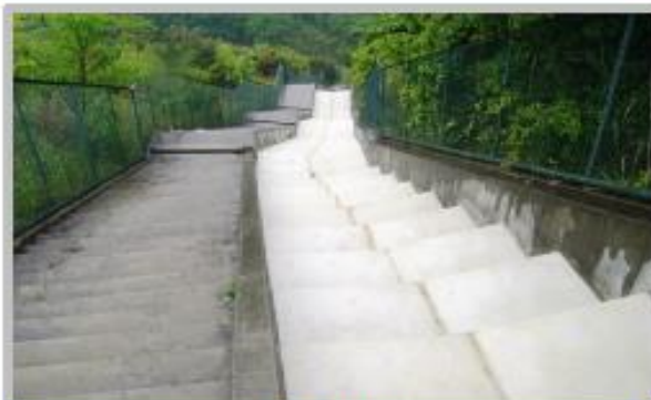
水路落差部補修
