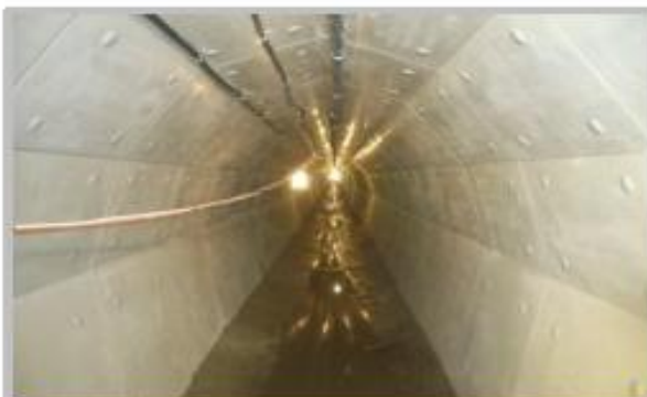
導水路トンネル補強
