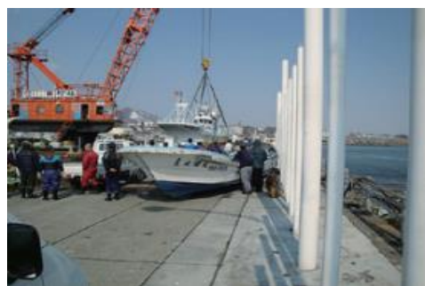
平成23年3月11日の東日本大震災により発生した津波において、津波バリアーが漁船等を捕捉。
