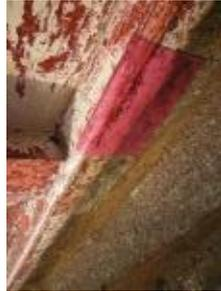
下地調整(ケレン)、プライマー塗布、不陸調整を行い紫外線硬化型FRPシート貼り付ける
