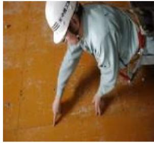
パネルの栈木の中央に4.5の釘を打って釘の頭にフラットキーパーを引っ掛けて調整している写真
