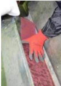
現場で樹脂を配合することがなく、下地にあわせて貼り付け、紫外線（太陽光）を当てただけで簡単に強靱なFRPを形成することができるため、工程の簡略化を図れる。
