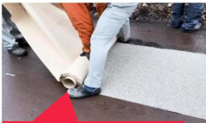
剥離紙を剥がして張り付けるだけ
