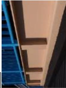
紫外線照射を行い、シートが硬化され、塗装を施し施工終了
