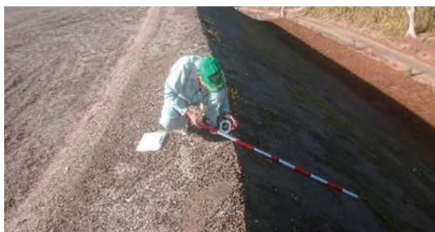
定期検査における法面勾配の確認
