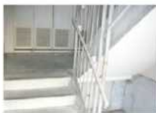
階段手摺の改修後
