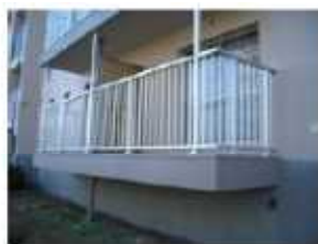
バルコニー手摺の改修後
