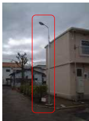
写真 2 防犯灯施工例
