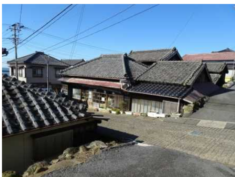
写真 6-5 銚子市外川漁港の町並み
