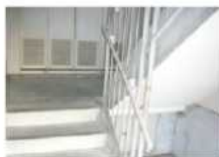
階段手摺の改修後
