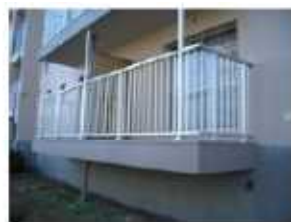
バルコニー手摺の改修後
