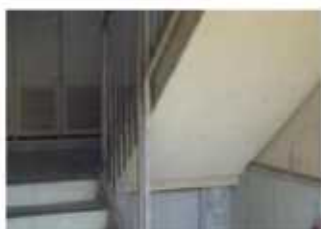
階段手摺の改修前
