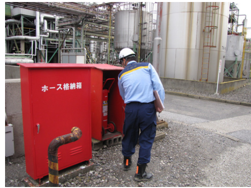
↑危険物施設への立入検査の状況
