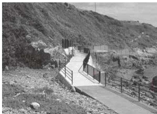
図表 2-2-3 再整備した遊歩道
