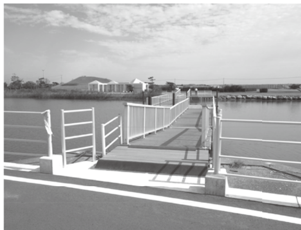
図表 2-2-3 改修した浮棧橋
