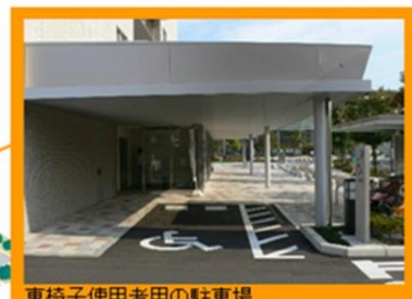
車椅子使用者用の駐車場
