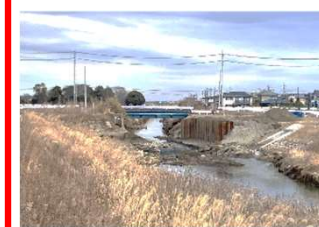
橋梁改築（中橋）
