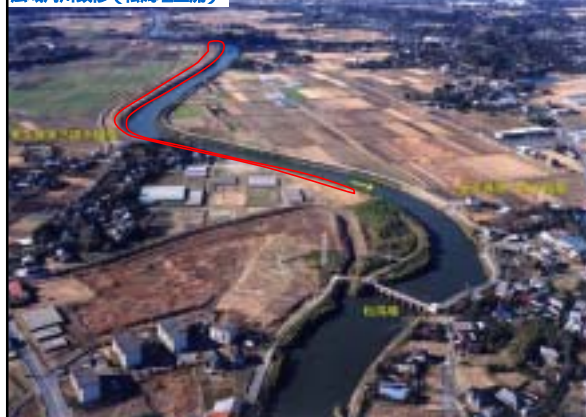
広域河川改修（松渦堰上流）
