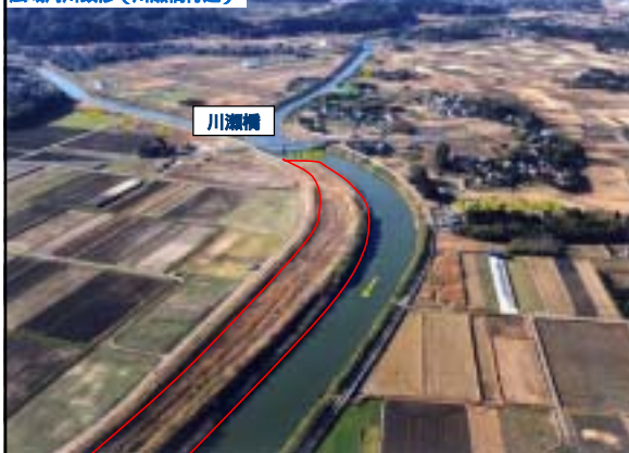
広域河川改修（川瀬橋付近）
