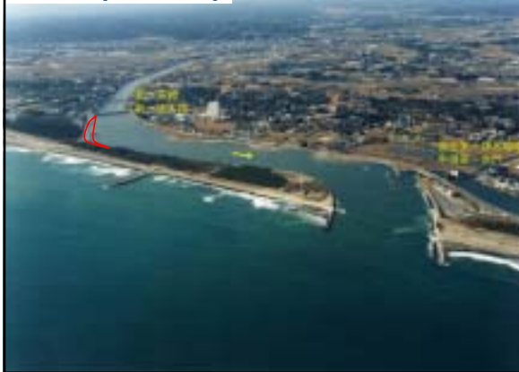
広域河川改修（河口～新一宮橋）
