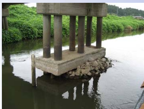
河床低下の影響を受けた橋脚 (新川橋) 河床低下により橋脚基礎部が露出
