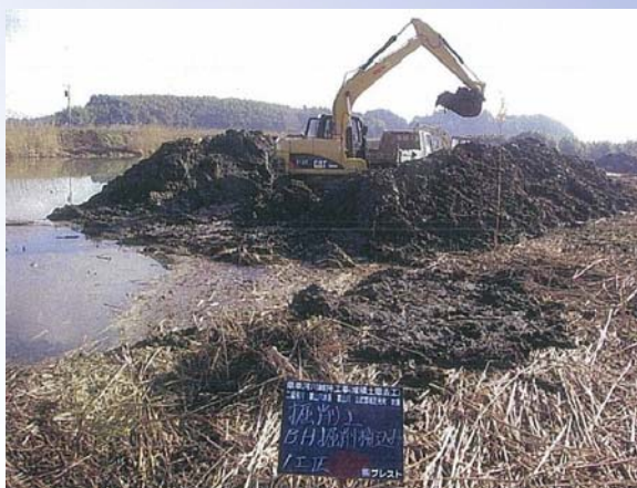
河道掘削状況
