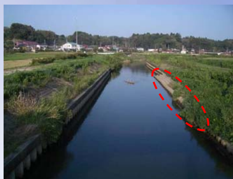
河床低下対策(護岸補強)として実施した根固工 (小池谷橋下流)
