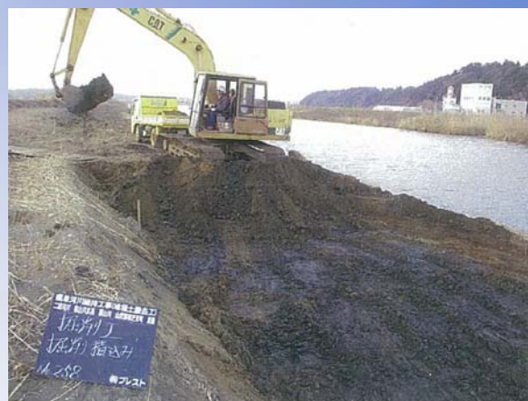
河道掘削状況2
