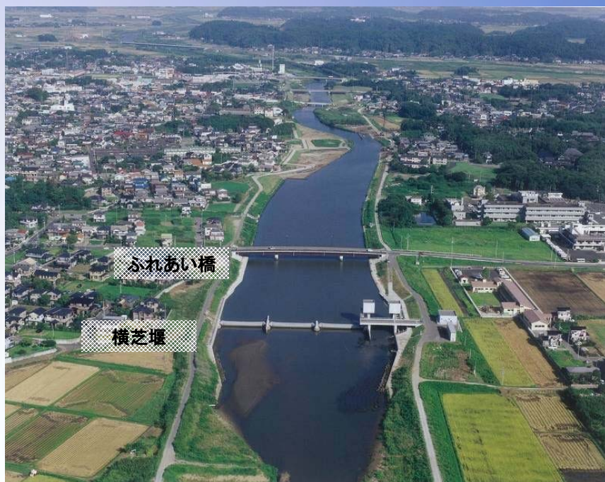
横芝堰周辺(河口から約6.0km)
