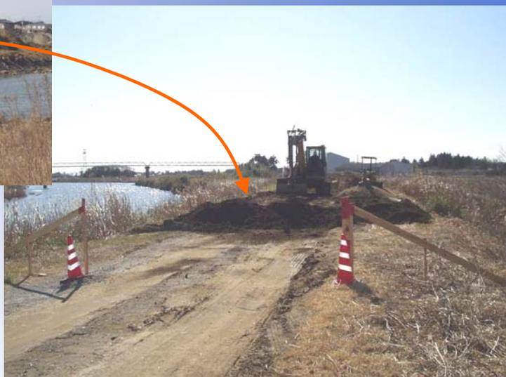
掘削土を再利用した築堤整備状況
