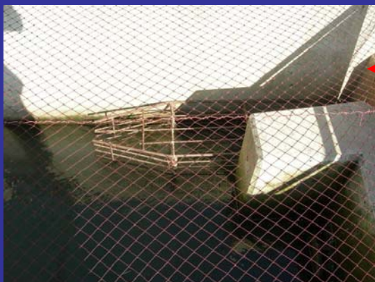
サケ採捕用の仕切(バーチカルスロット型魚道最上部)
