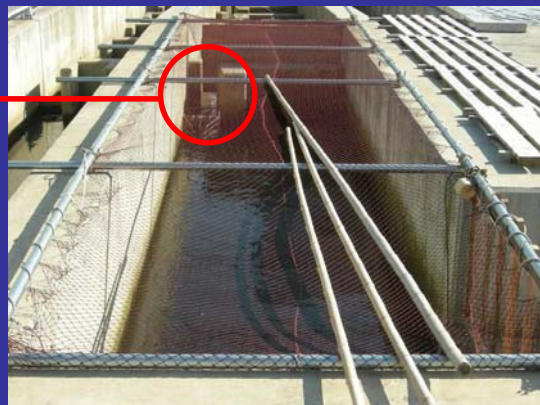
サケ採捕用の仕切(バーチカルスロット型魚道最上部)
