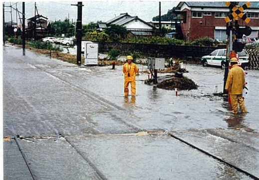
H8. 9/22 洪水（JR 線路の冠水状況）
