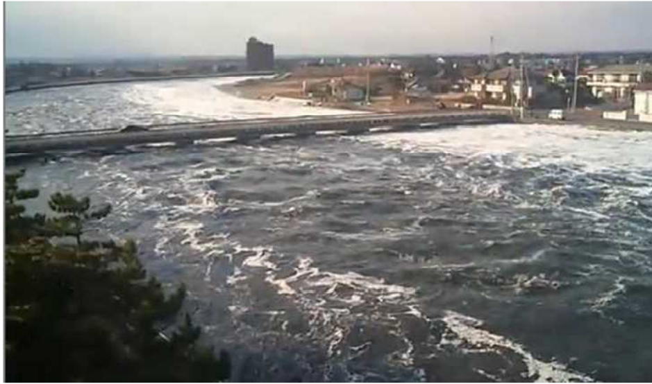
■ 津波の遡上の様子（旭橋）
