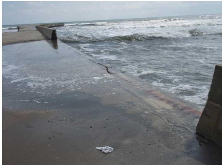
■ 河口左岸の護岸堤防倒壊
