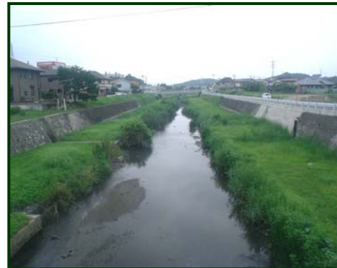
砂子橋より上流側の現在の状況
