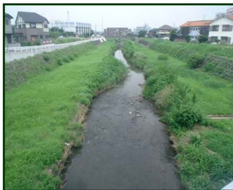
川間橋より下流側の現在の状況
