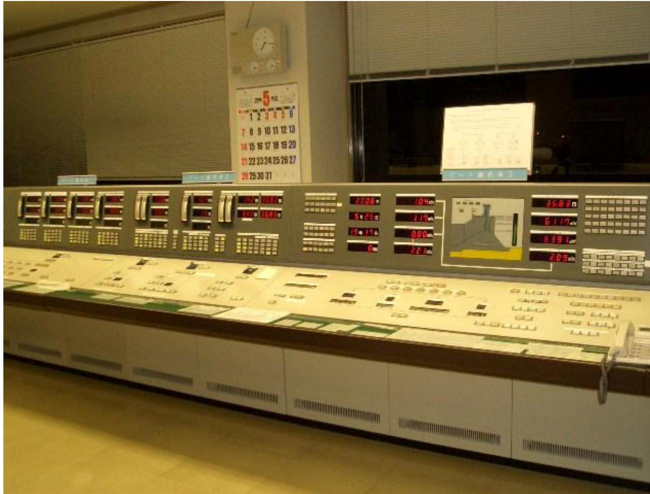
ダムコンピュータは、雨量、水位のデータからダム流入量と放流量を計算し、操作員の操作を支援するとともに、ゲートなどの放流設備を制御する設備です。
