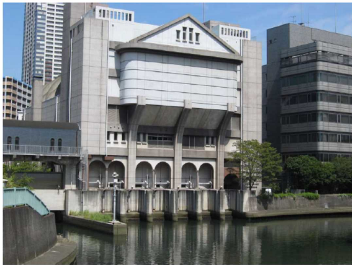
葭川排水機場(下流側から)
