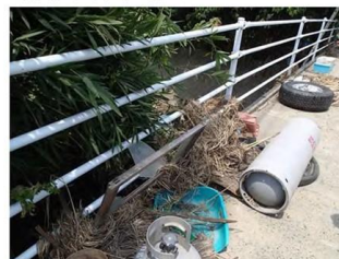
ゴミの付着状況、植物の状態から最高水位、流れを推測
