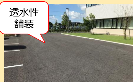
雨水貯留浸透施設（浸透）の事例
