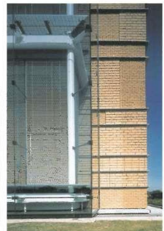
自然素材を様々なパターンにより積層させたレンガ中空積工法
