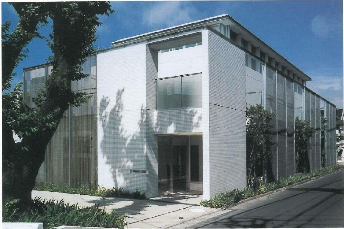
診療所エントランス側からの外観
