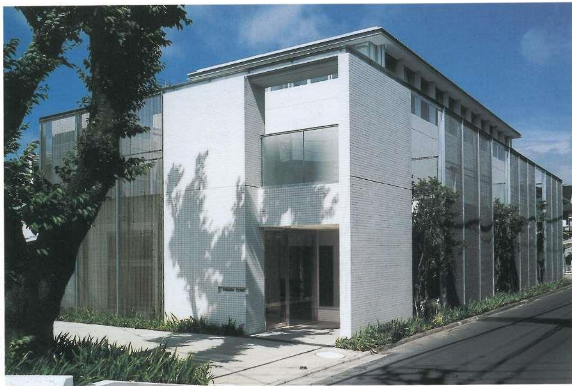
診療所エントランス側からの外観
