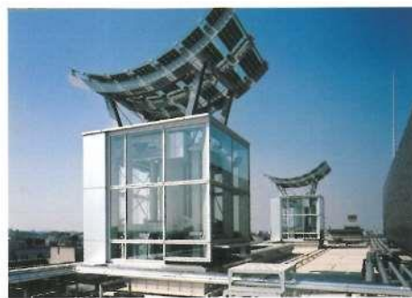
ソーラーチムニー頂部
